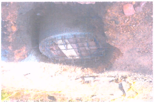
ARMADO DE LOSA
