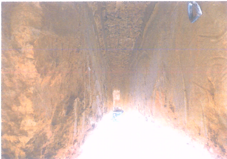
EXCAVACION DE ZANJA P315 - P321
