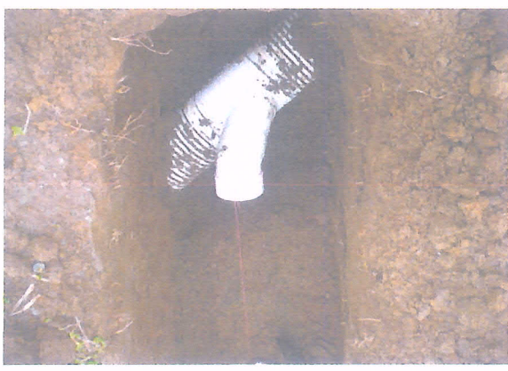
COLOCACION CODO 160 mm. * 45
