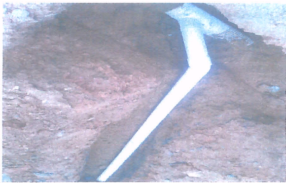
EXCAVACION A MANO Y COLOCACION DE TUBERIA 160 mm.
