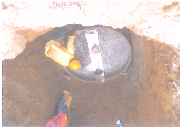
POZOS DE REVISION FUNDICION DE ANDENES - PAREDES - LOSA
