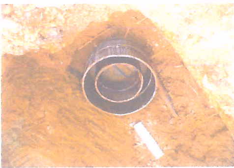
ENCOFRADO DE POZO
