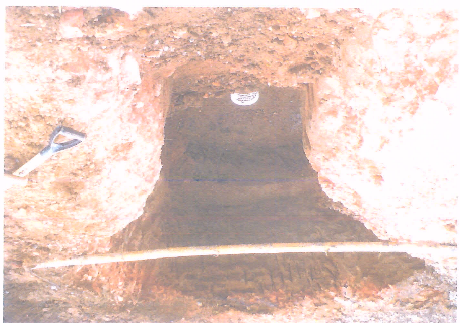
EXCAVACION A MANO PARA POZOS
