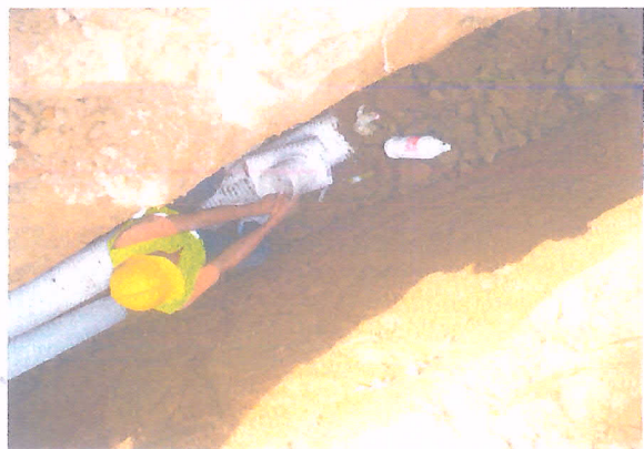
COLOCACION SILLA YEE 160 mm.
