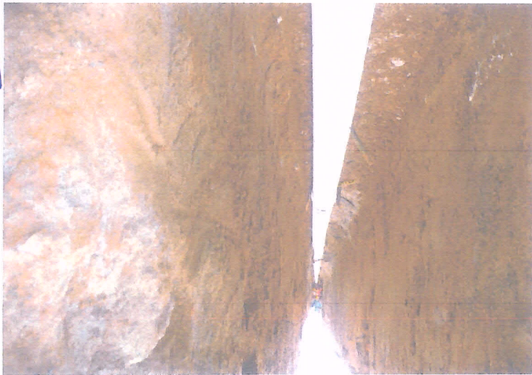
COLOCACION DE TUBERIA 250 mm.
