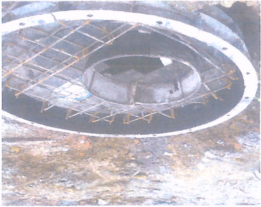
ENCOFRADO DE LOSA
