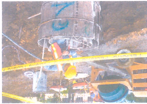
FUNDICION DE POZO
